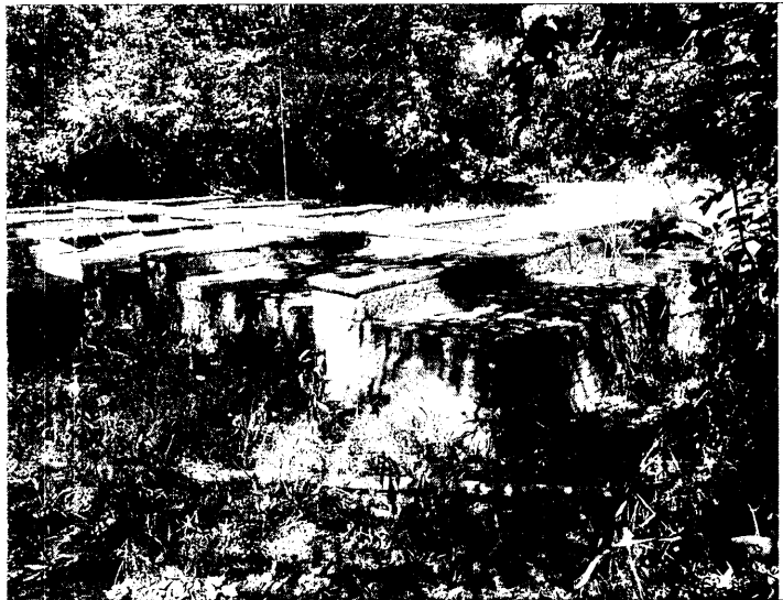
Imagen No 1. PTAR del Municipio de Puerto Caicedo Fuente: Este concepto
